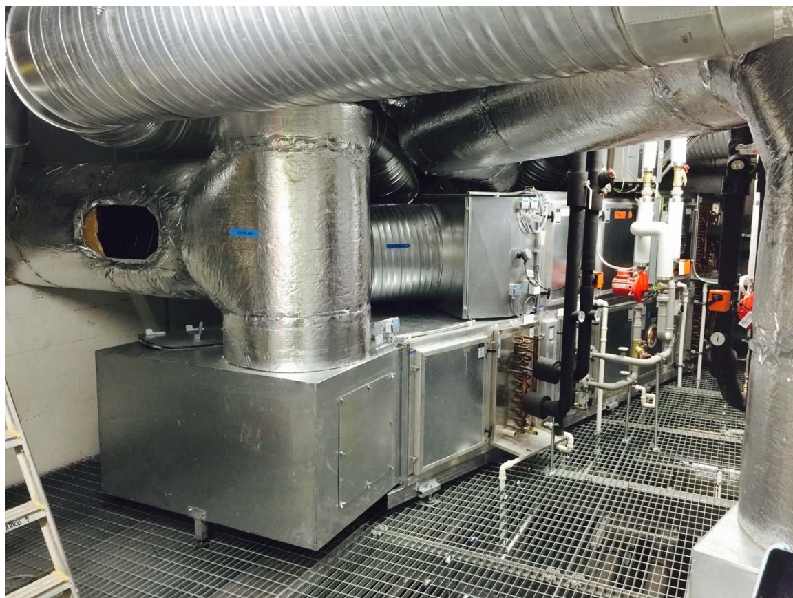
Kuva 3 Ilmanvaihtokonehuoneet ovat valmiit. Toimintakokeita varten ilmaa puhallettiin konehuoneeseen.
