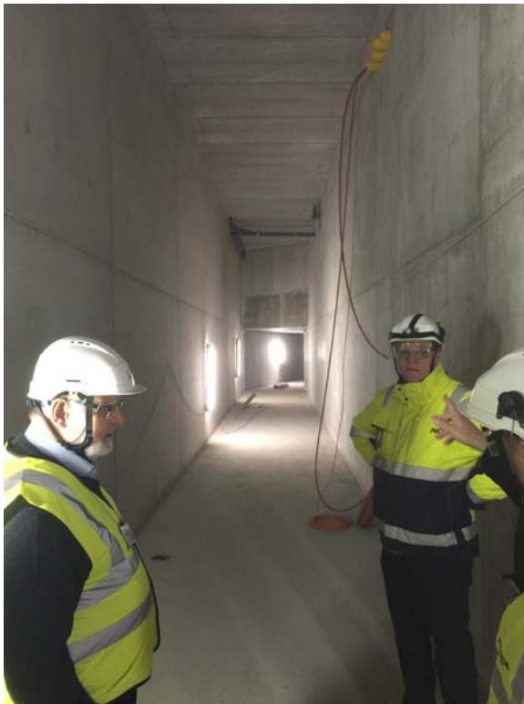
Kuva 2 Vastaanoton työmaakerroksella Kiiras ja Räsänen
