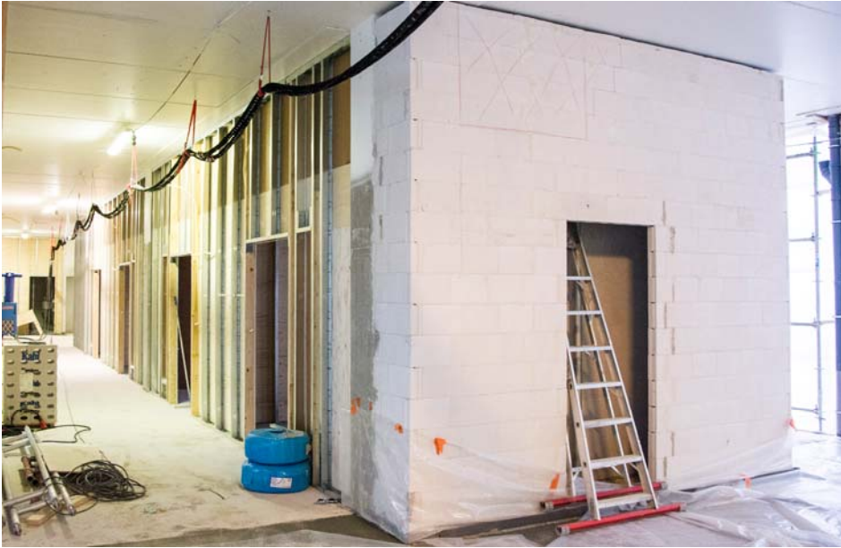
Toisessa kerroksessa mielenterveys- ja päihdetyöyksikön vastaanottohuoneiden väliseinätyöt ovat käynnissä (kuva 3). Kolmannen kerroksen työterveyshuollon tilojen osalta väliseinätyöt ovat jo pidemmällä.
