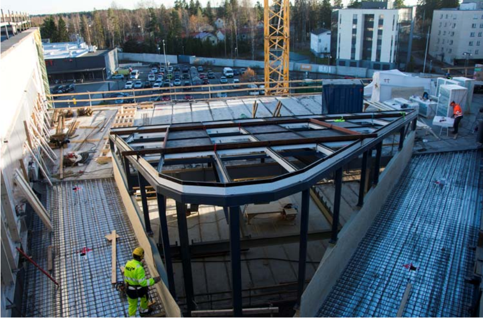
Katolla pääaulan yläpuolelle sijoittuvan valokaton runko on asennettu paikoilleen. (Kuva 5). Pysäköintitalossa ensimmäisen kerroksen holvin valutyöt ovat käynnissä.
