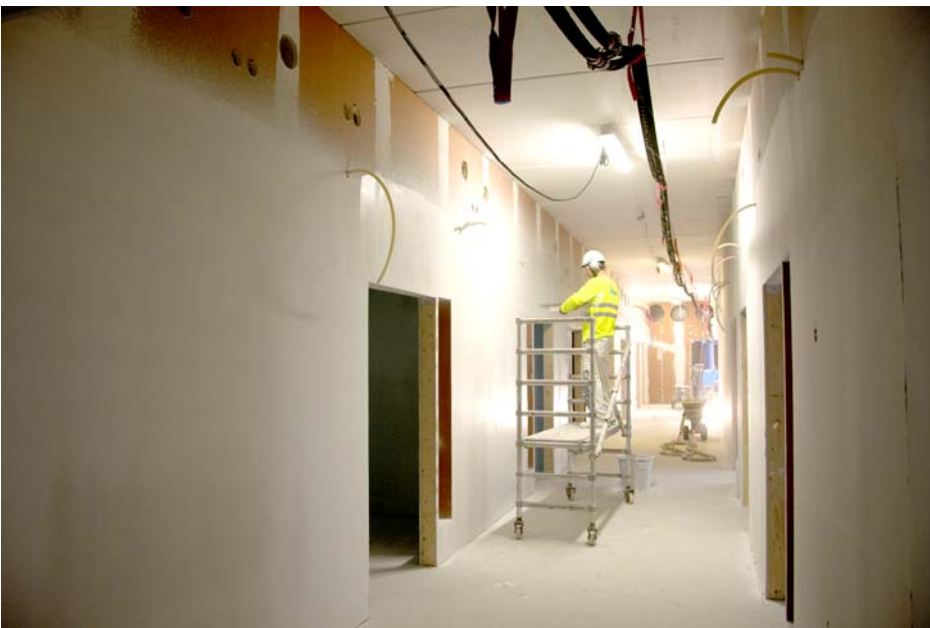
Kolmannen kerroksen hallinto- ja vastaanottotiloissa tasoite- ja maalaustyöt ovat käynnistyneet (kuva 4). Neljännen kerroksen potilastiloissa lattia on valettu.
