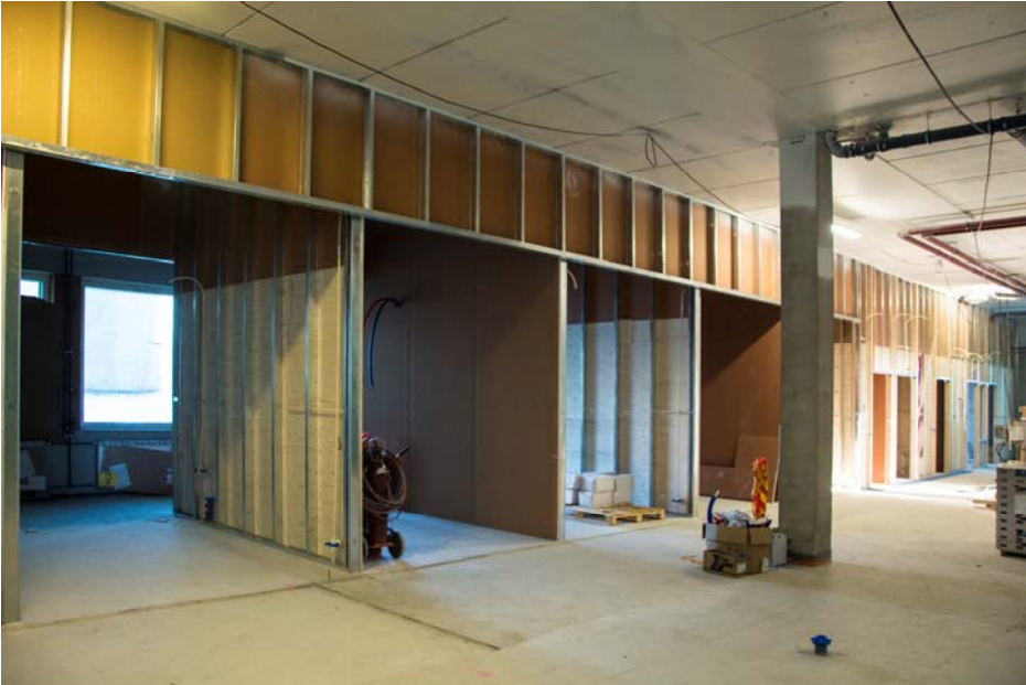
Toisessa kerroksessa mielenterveys- ja päihdetyöyksikön vastaanottohuoneiden väliseinätyöt jatkuvat (kuva 3).
