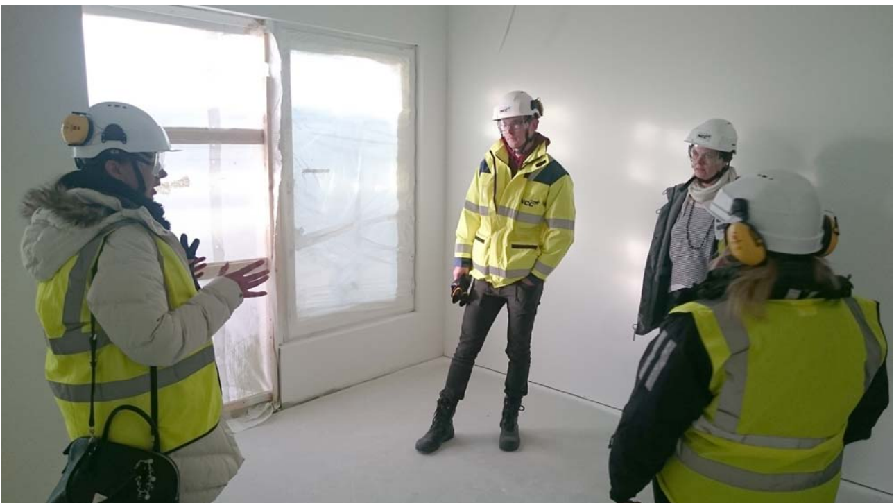
Käyttäjiä tutustumassa akuuttiosaston potilashuoneisiin. Tasoite- ja maalaustyöt ovat käynnissä useassa kerroksessa (kuva 4).
