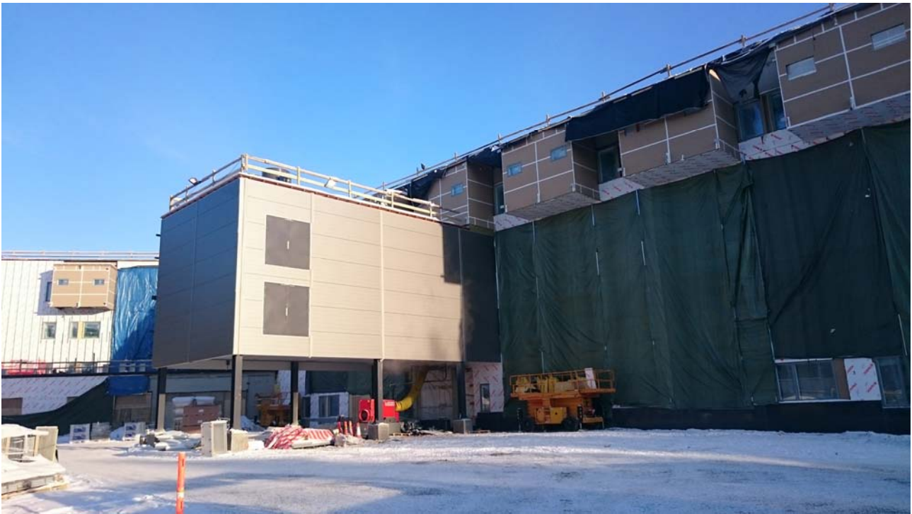
Julkisivun eristystyöt ovat pääosin valmiit (kuva 1). Helsinginkadun puolella metallilasiseinät on asennettu paikalleen.
