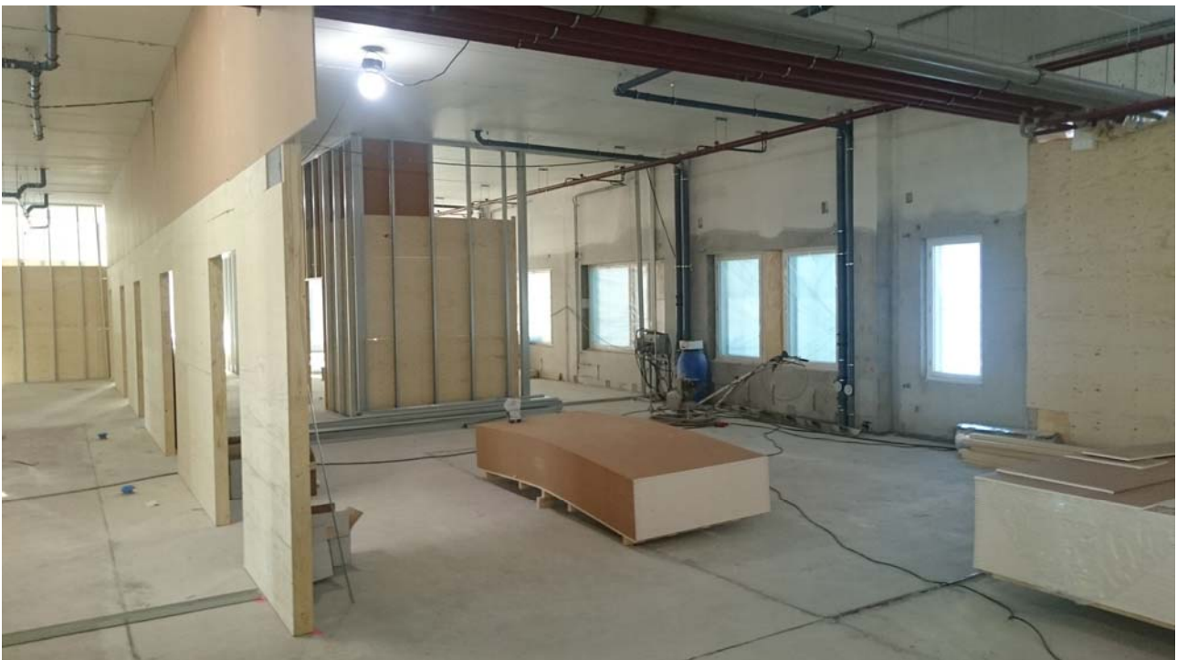
Ensimmäisen kerroksen päiväystiloissa on käynnissä väliseinien asennustyöt (kuva 2).
