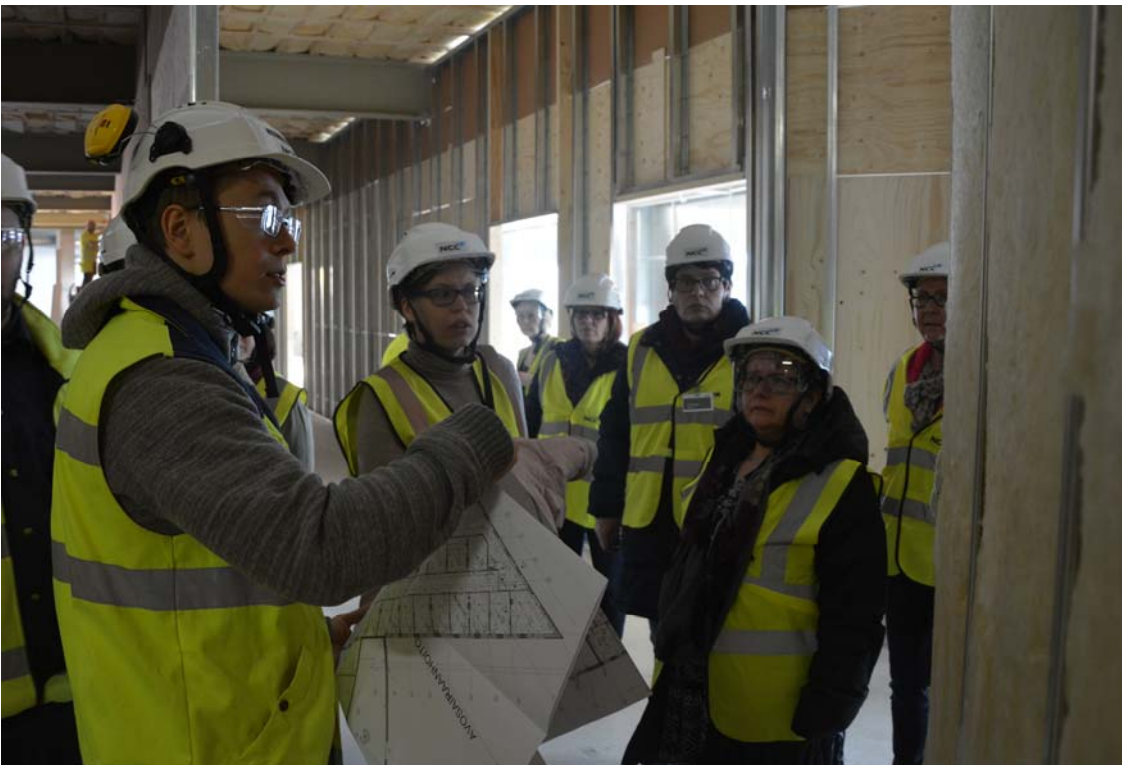
Osassa rakennusta väliseinätyöt ovat vielä käynnissä. Kolmen ylimmän kerroksen väliseinäasennustyöt ovat pääosin valmiit. Kuvassa on käyttäjiä Järvenpään eri palvelusektoreilta tutustumassa tuleviin työtiloihin (kuva 4).
