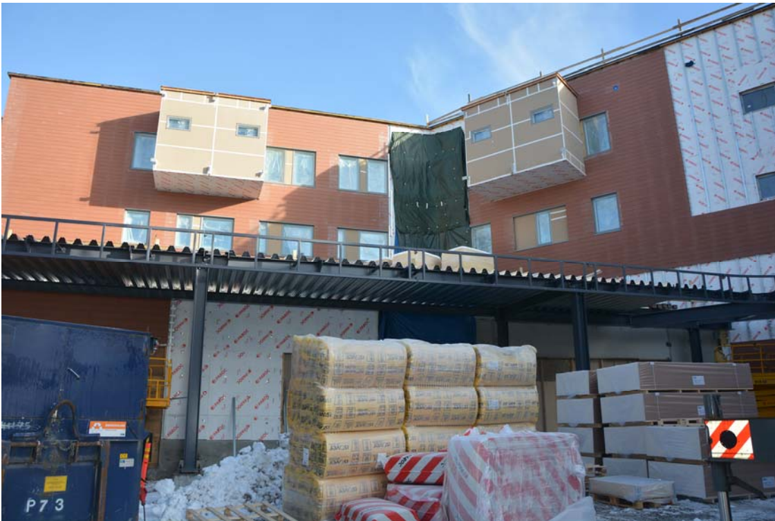
Tiililankkuverhouksen asennustyöt ovat valmiit Myllypolun puolella. Asennukset muilla julkisivuilla jatkuvat (kuva 1).
