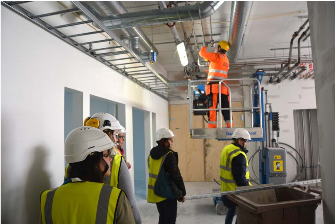
Neljännän kerroksen ilmanvaihtotyöt ovat valmiit ja putkityöt käynnissä (kuva 5).
