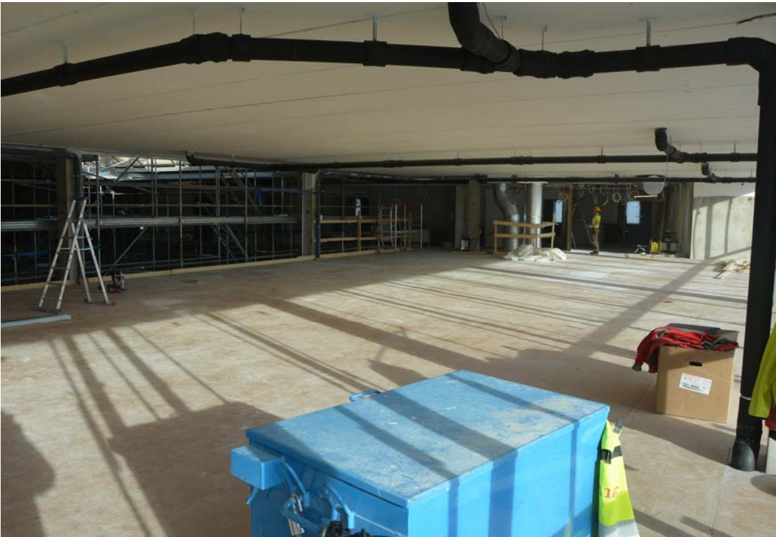
Kolmannessa kerroksessa sisääntuloaulan yläpuolisen puuvälipohjan viimeistelytyöt ovat edistyneet (kuva 3).
