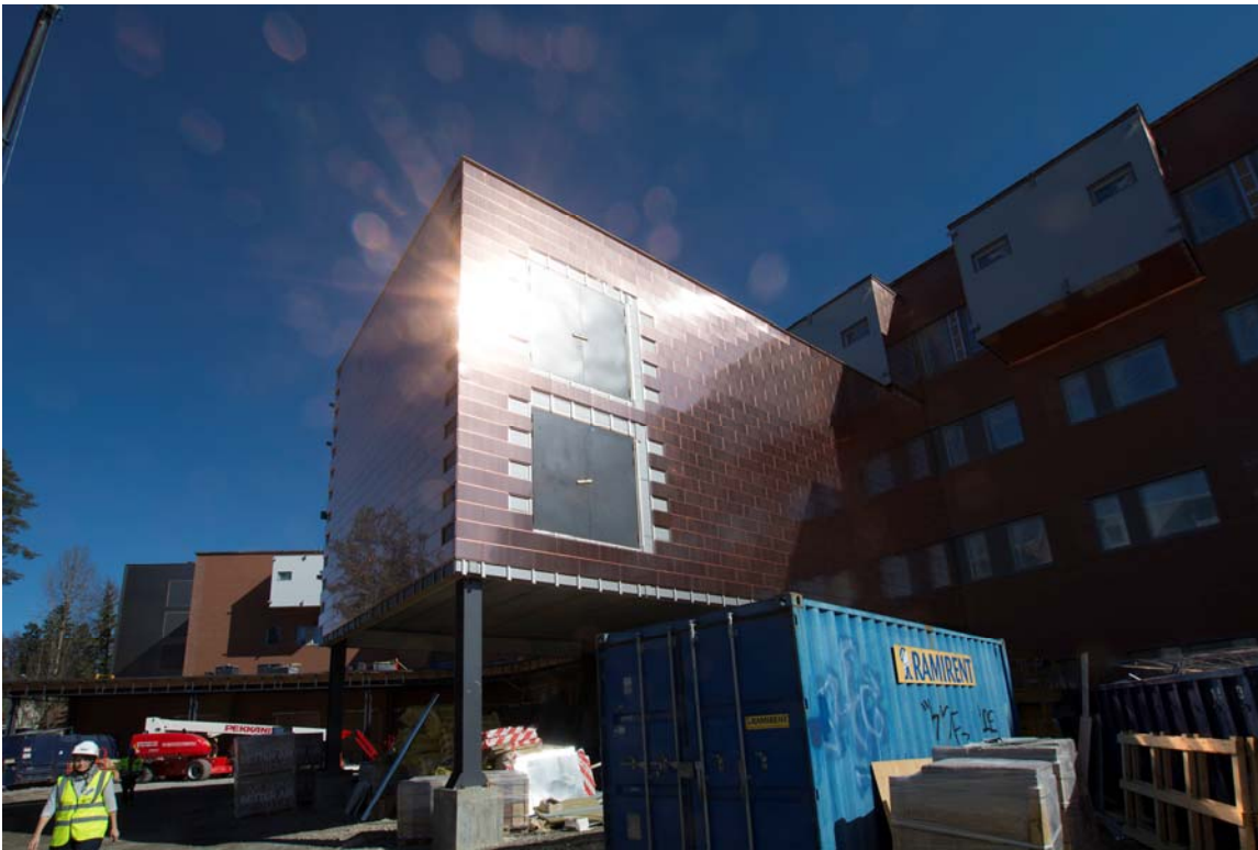
Julkisivun kuparikasettien asennustyöt ovat käynnissä (kuva 1).
