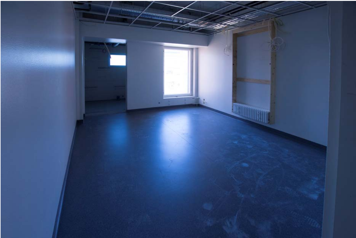
Mattotyöt ovat käynnissä akuuttiosastolla ja kuntoutuksen tiloissa (kuva 3).
