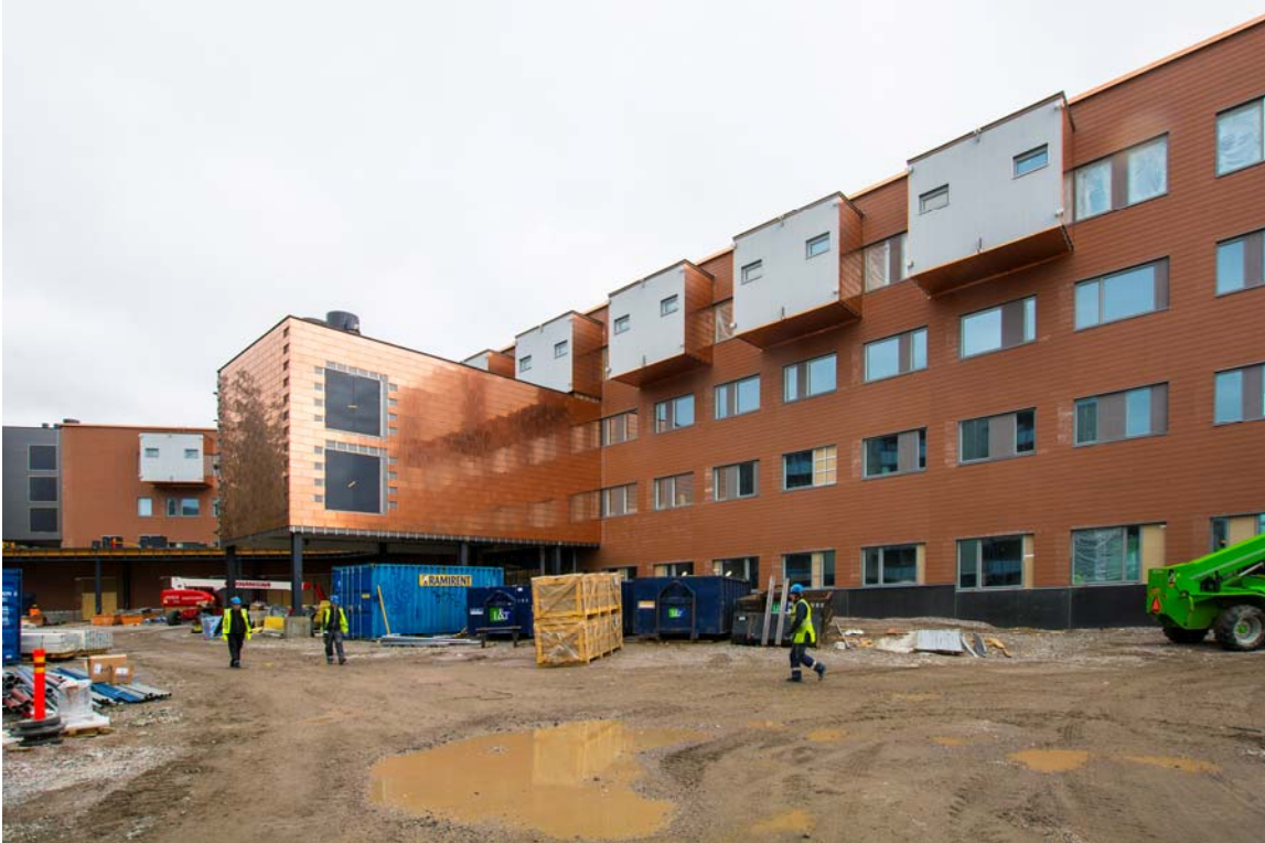
Julkisivun kuparikasettien asennustyöt jatkuvat (kuva 1).
