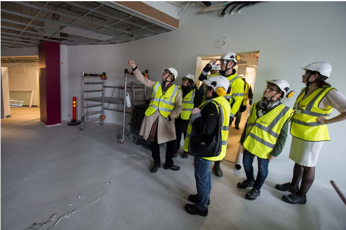
3. kerroksen kuntoutuksen jumppasali edistyy (kuva 4).
