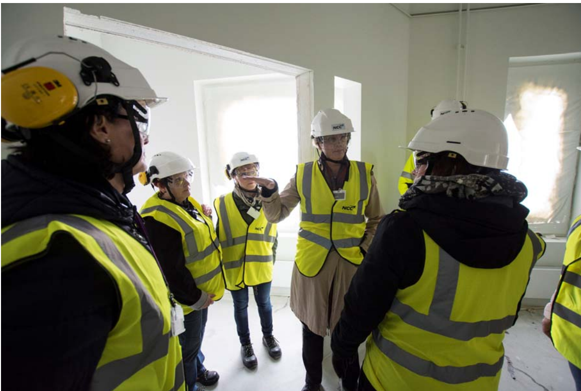
Osastoilla asennustyöt jatkuvat, seinät on maalattu lähes jokaisessa kerroksessa. Kuvassa käyttäjiä tutustumassa tiloihin (kuva 2).
