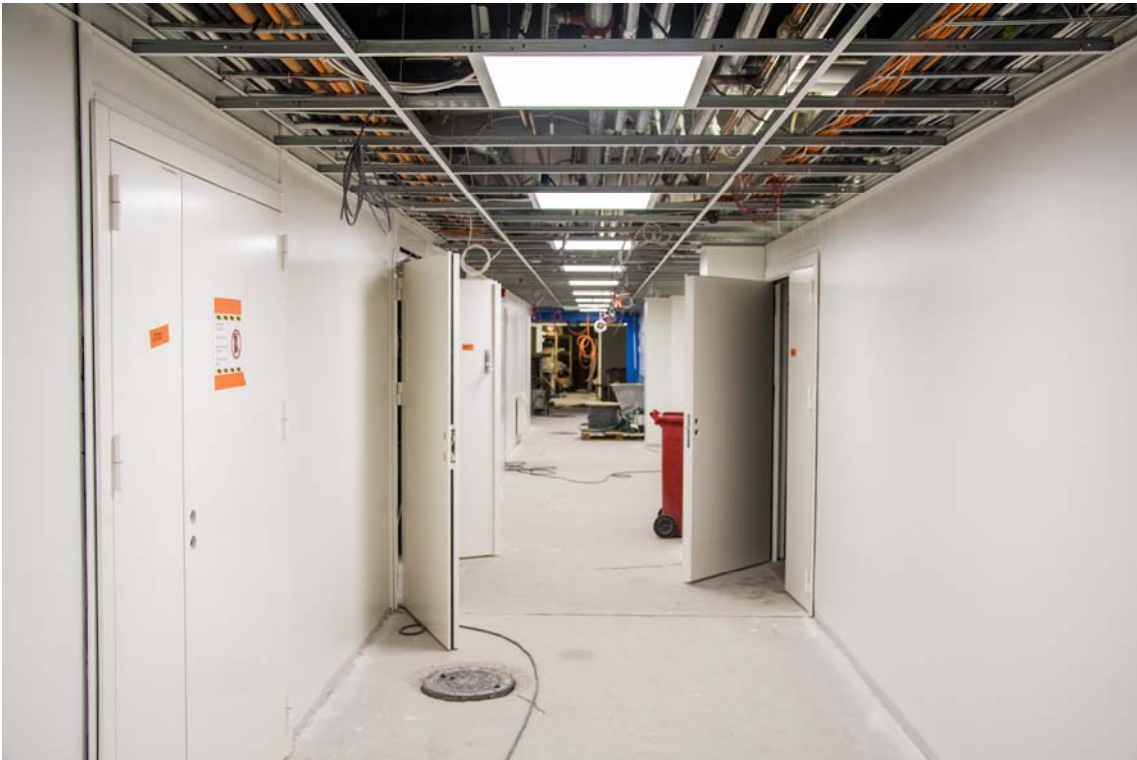
Kellarikerroksen valaisinasennukset ovat pitkällä (kuva 3).
