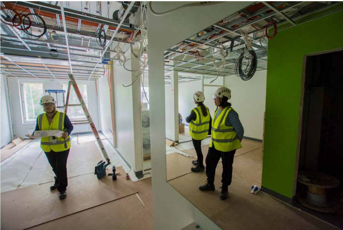
Talotekniset asennustyöt ovat käynnissä useilla tila-alueilla (kuva 2).
