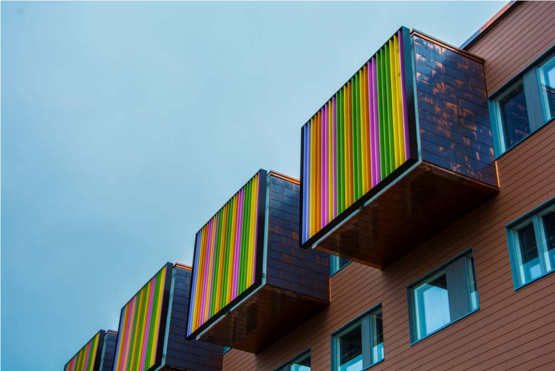
Julkisivun kuparikasettien asennustyöt ovat valmiit (kuva 1).
