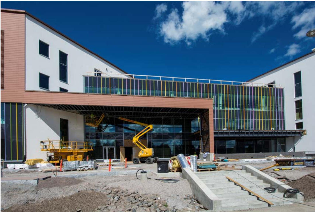
Pihakivetystyöt jatkuvat pääsisäänkäynnin alueella (kuva 1).
