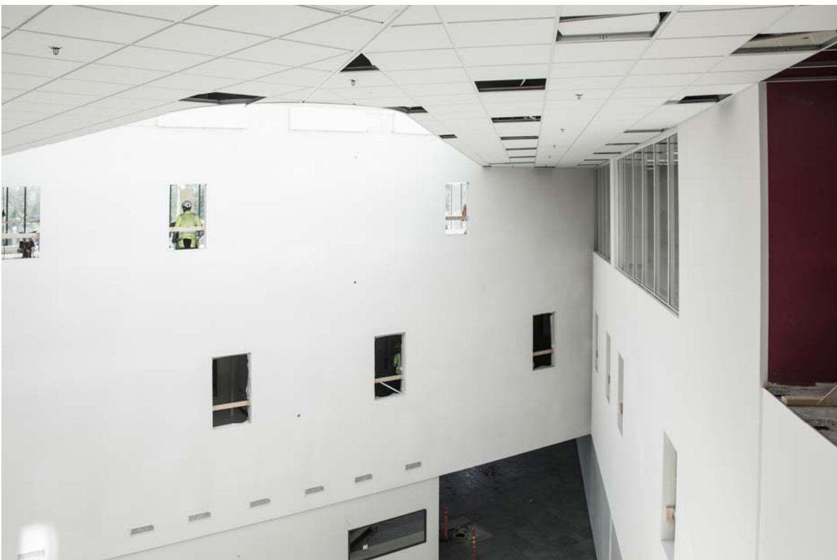
Valokatteen alla olevassa korkeassa tilassa erilaiset asennustyöt jatkuvat (kuva 4).
