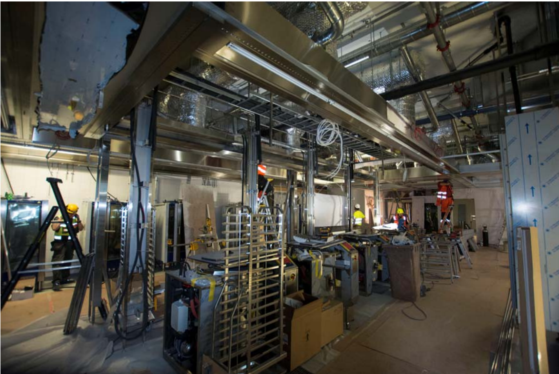
Keittiölaitteiden asennustyöt ovat käynnissä ensimmäisessä kerroksessa (kuva 2).
