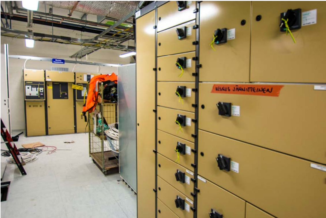
Sähköpääkeskuksessa asennustyöt jatkuvat (kuva 5).
