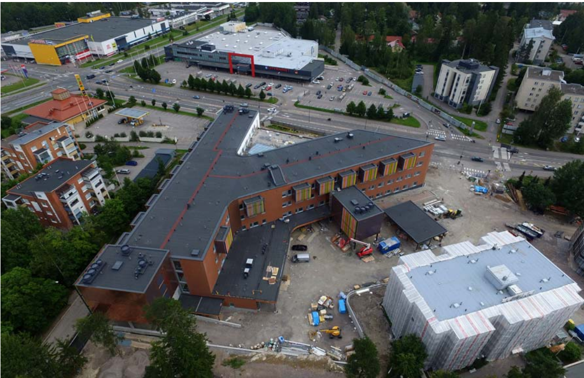
4. kerroksen ulkoterassin kivetystyöt ovat käynnissä (kuva 1).
