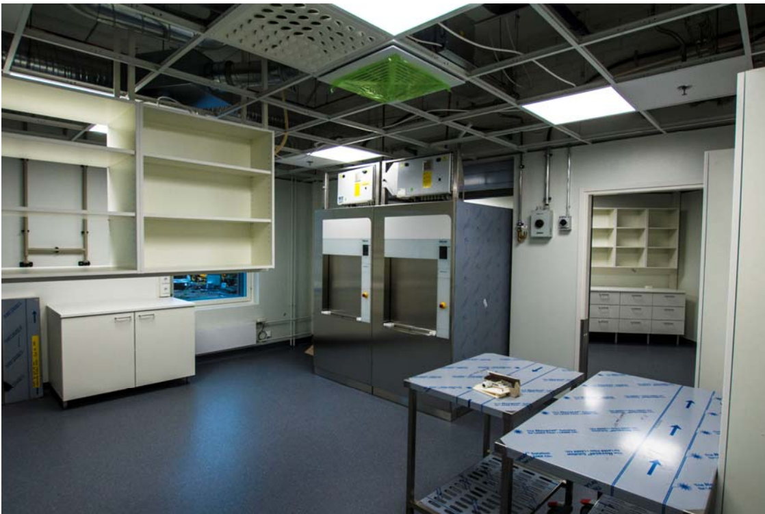
Kaluste- ja laiteasennukset ovat käynnissä välinehuollon tiloissa (kuva 4).
