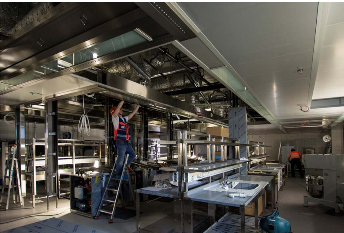
Keittiölaitteiden asennukset ovat käynnissä (kuva 4).
