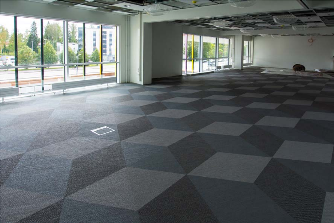
Valmis lattiamattoasennus koulutustilassa (kuva 3).
