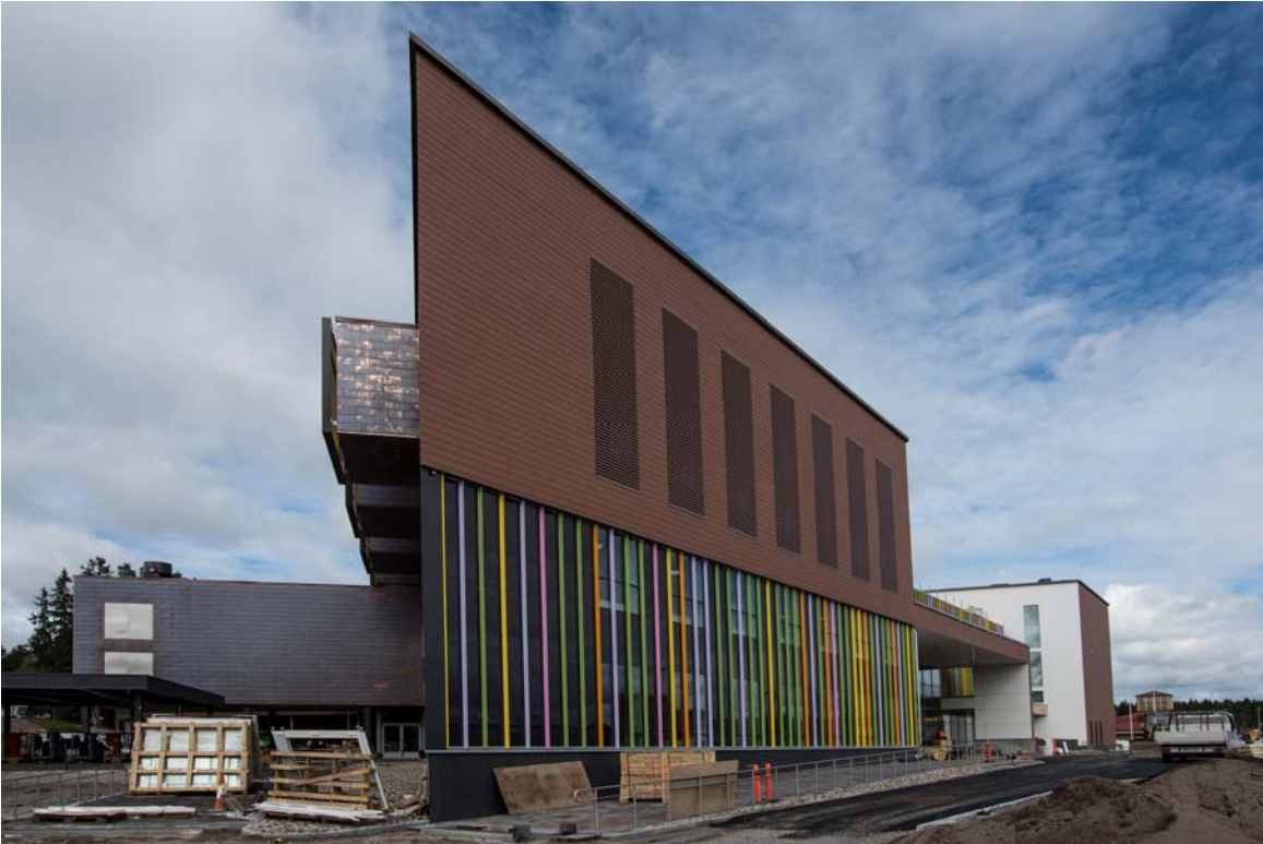
Sisäpihan asfaltointityöt aloitettiin viikolla 34. Viimeistelytyöt jatkuvat pääsisäänkäynnin ympärillä. (kuva 1).
