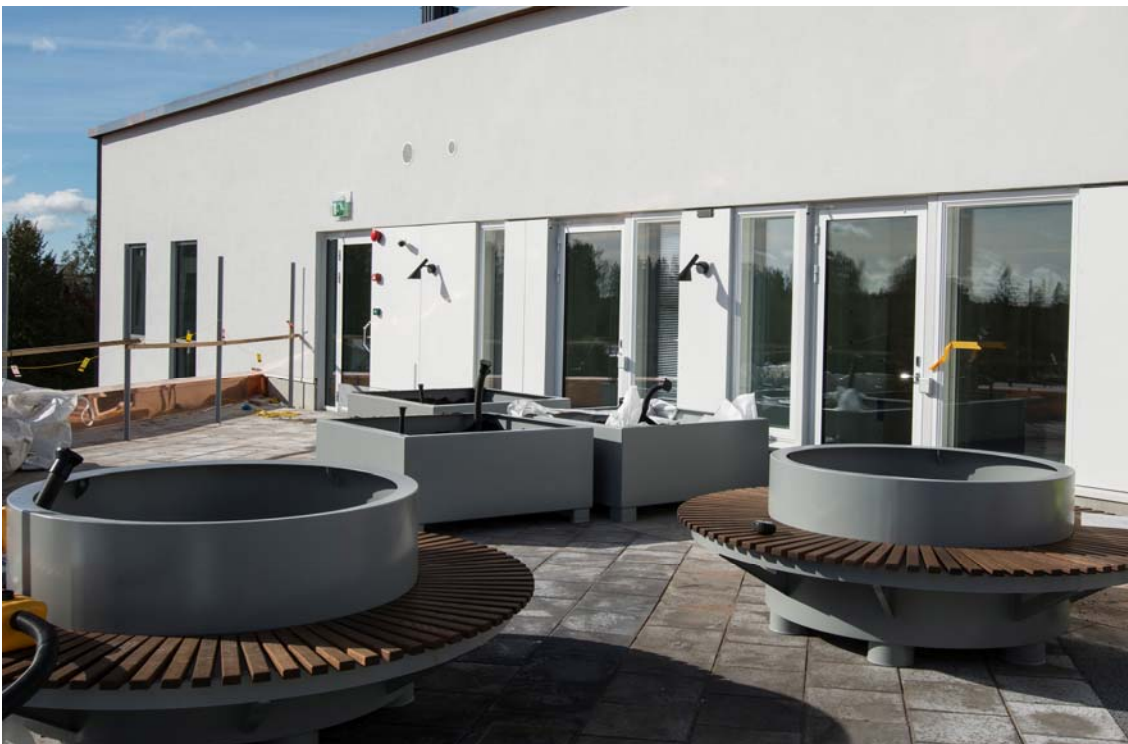
Ulkoiluterassin kalusteasennukset ovat käynnissä (kuva 4).
