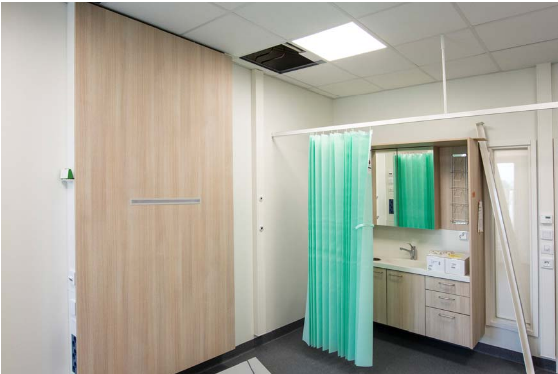
Potilashuoneissa asennukset jatkuvat ja mm. erilaisia verhovaihtoehtoja testataan (kuva 3).
