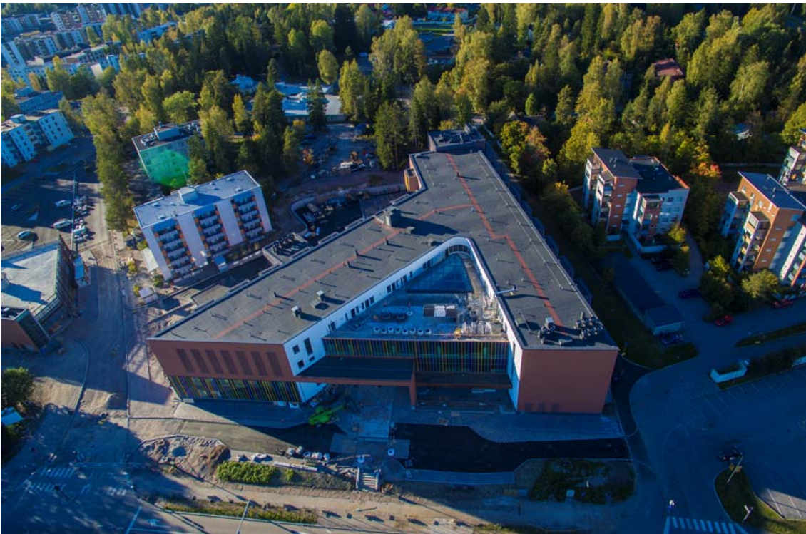
Aluerakennustyöt ovat käynnissä (kuva 1).
