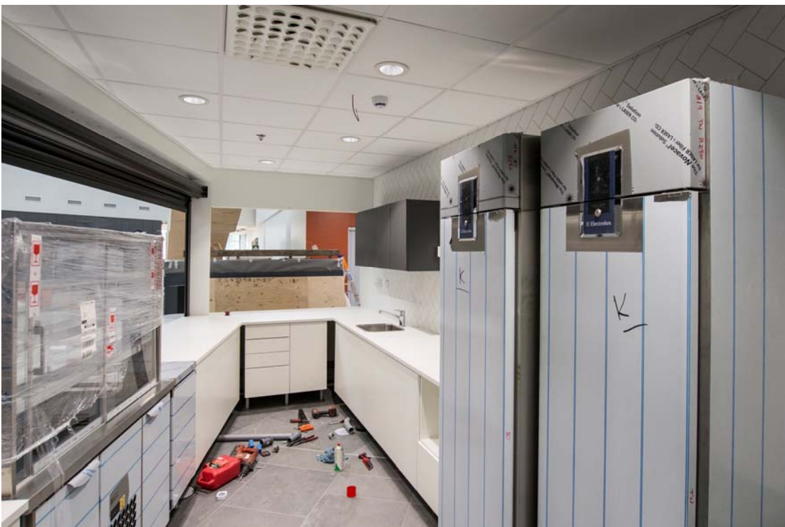
Kantiinin kalusteasennukset ovat pitkällä (kuva 2).
