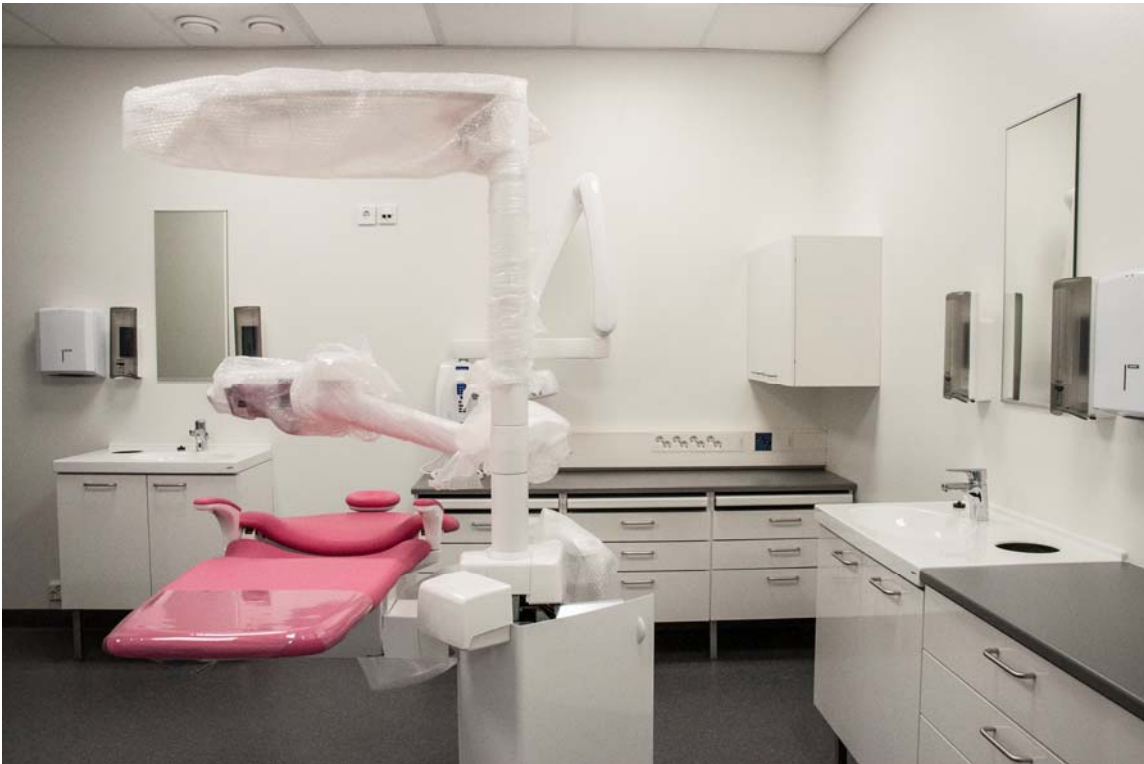
Suunterveydenhuollon vastaanottotiloja (kuva 3).
