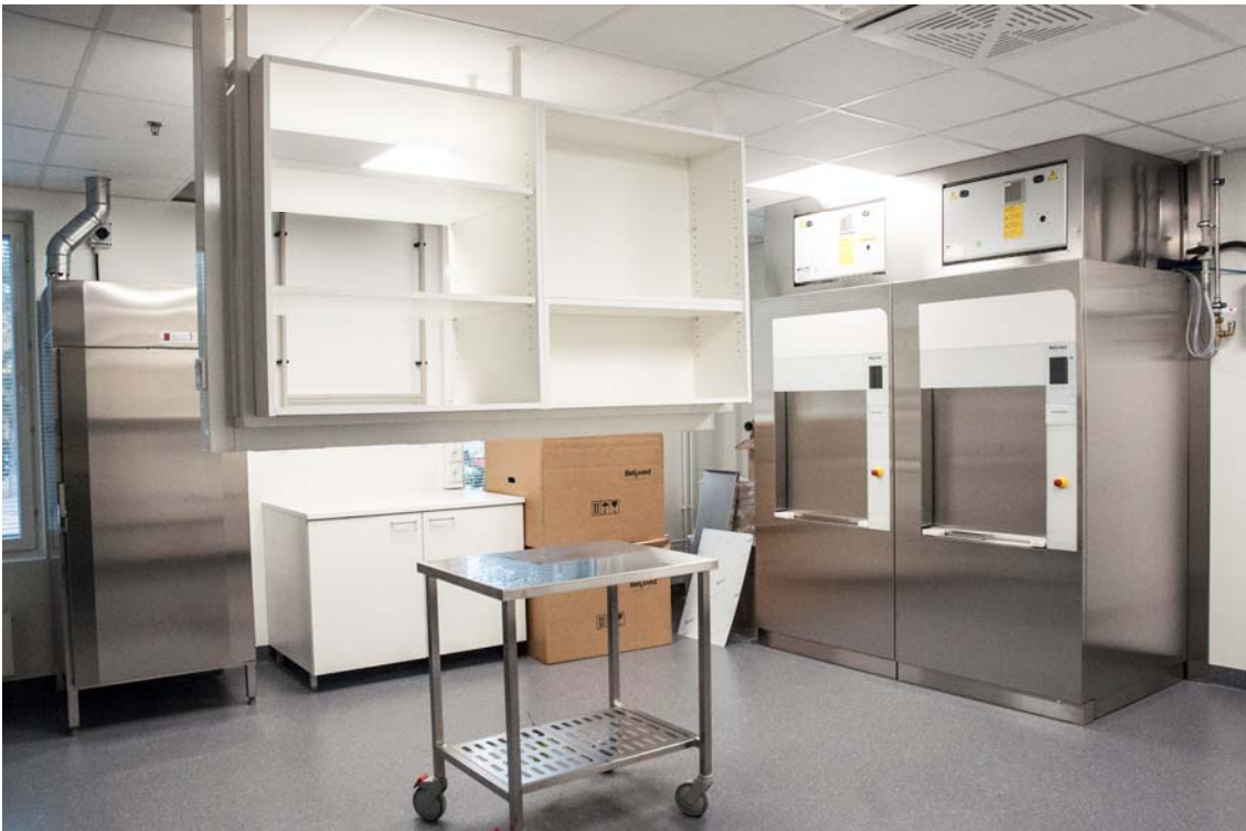
Kalusteasennukset ovat pääosin valmiit (kuva 2).
