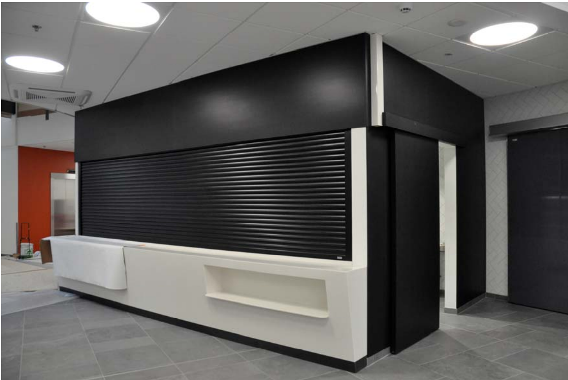
Kalustusten viimeistely jatkuu, kiinteät kalusteet on asennettu (kuva 1).
